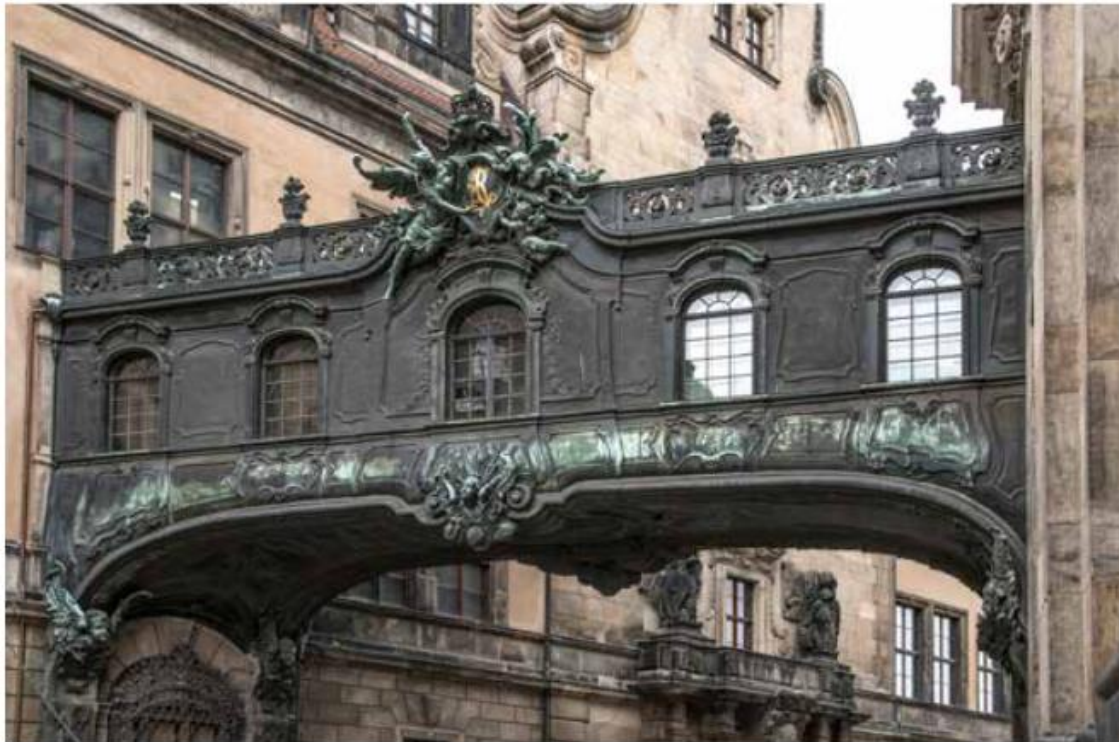
Abb.4 Brücke zwischen Dresdner Residenzschloss und Hofkirche mit in Kupfer getriebenen Figuren [5]
